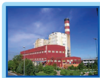
نیروگاه حرارتی تبریز
